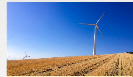
Impianto Eolico da 60 kWe
